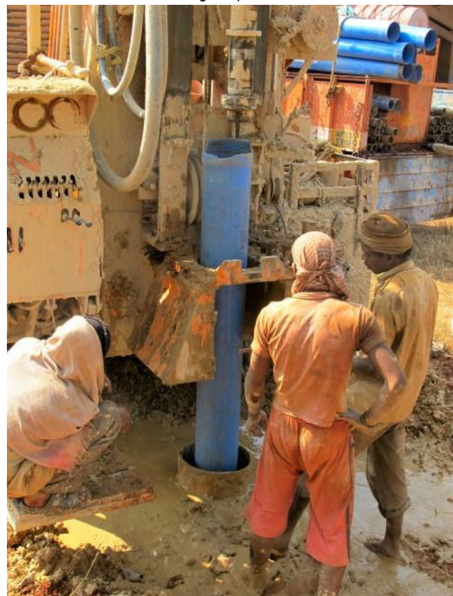
Forage de puit artésien, Kechala, Orissa, Inde
