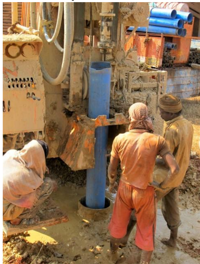
Bohrung eines artesischen Brunnens, Kechala, Orissa,
