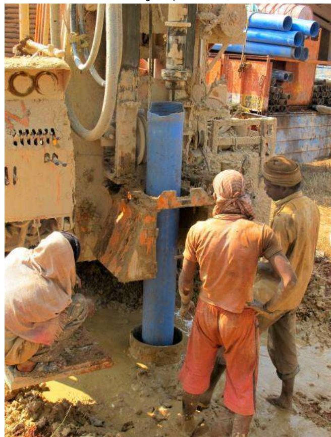
Forage de puit artésien, Kechala, Orissa, Inde
